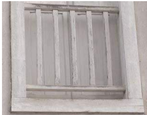
Exemple d'architecture ariégeoise : barreaudage en bois
