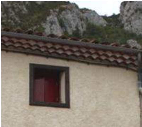
Mise en œuvre d'une génoise avec une gouttière de récupération des eaux de pluie.
