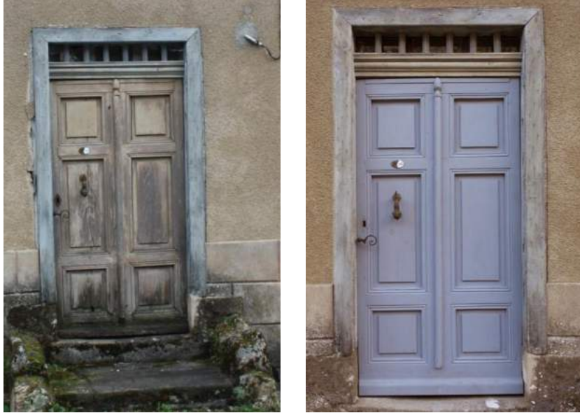
porte d'entrée avant restauration.....et après restauration
