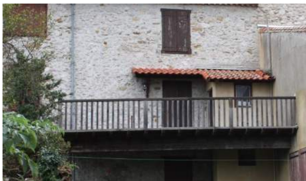
Garde corps en bois à lisses verticales et main courante en partie haute
