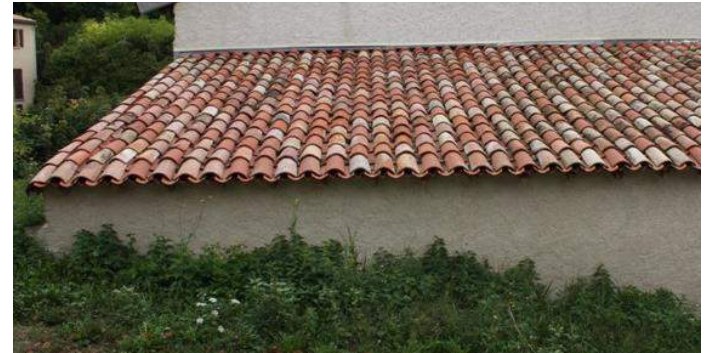
Toiture en tuiles "canal" vieillies.
