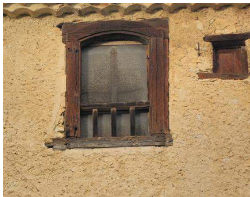
Fenêtre sous toiture avec balustre en bois
