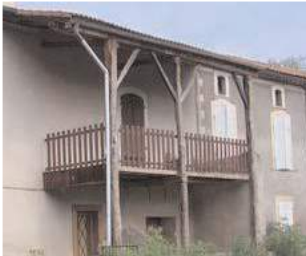
Garde corps en bois à lisses verticales et main courante en partie haute
