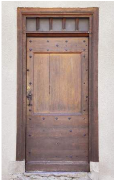
portes d'entrée restaurées
